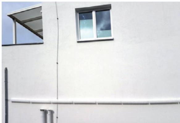
Um dies zu verhindern haben wir eine entsprechende Applikation entwickelt, die schnell und einfach mittels Spanngurten montiert werden kann. Die Bürsten besitzen an jedem Ende einen Haken, mit dem sie einfach verbunden werden. Mittels zweier mitgelieferter Spanngurte werden die Bürsten nun am potenziellen Aufstiegsweg fixiert. Der Marder hat nun keine Chance mehr in diesem Bereich nach oben zu klettern.
