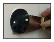
2. Die befestigen Montageplatten können auch mit einem dünnen Spachtel hinterstochen und somit entfernt werden.
