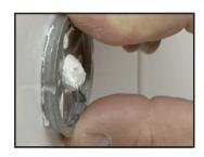
6. Montageplatte an die Wand drücken. Der Kleber kann je nach Witterung bis zu 15 Minuten verarbeitet werden.
